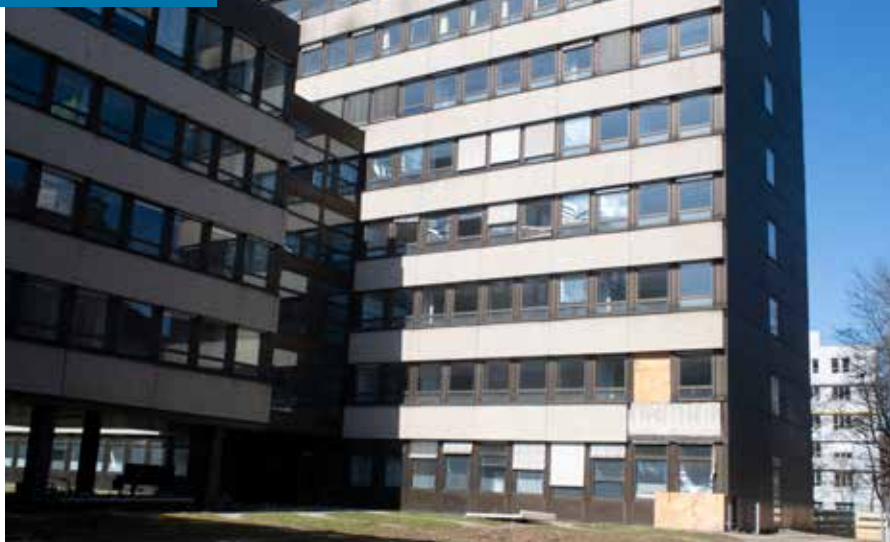
Das abrisssreife „Hochhaus“ in der Deroystraße.
